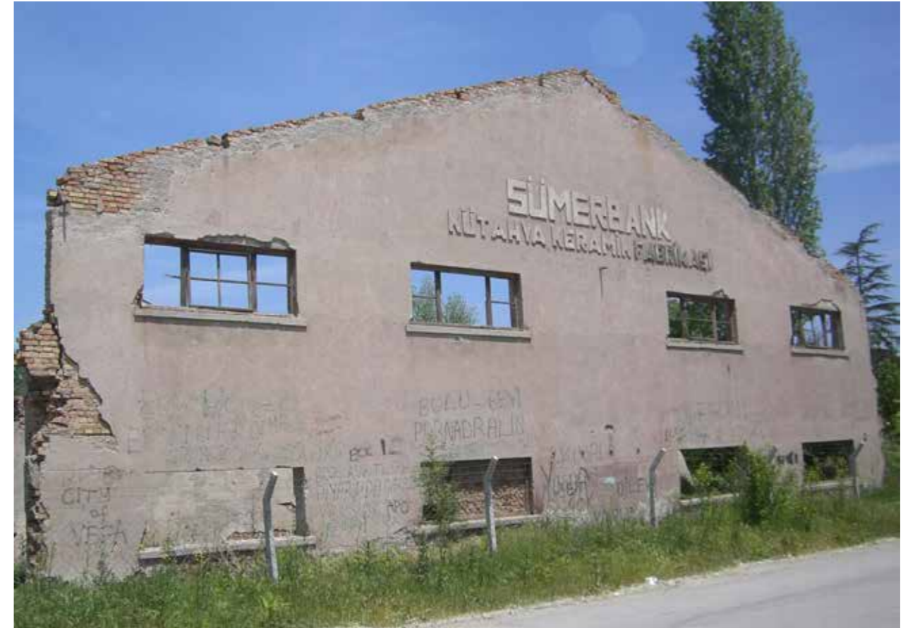
Abb. 10: Die Ruine der alten Ziegelfabrik in Kütahya R. 10: Kütahya'daki eski kiremit fabrikasının harabesi
